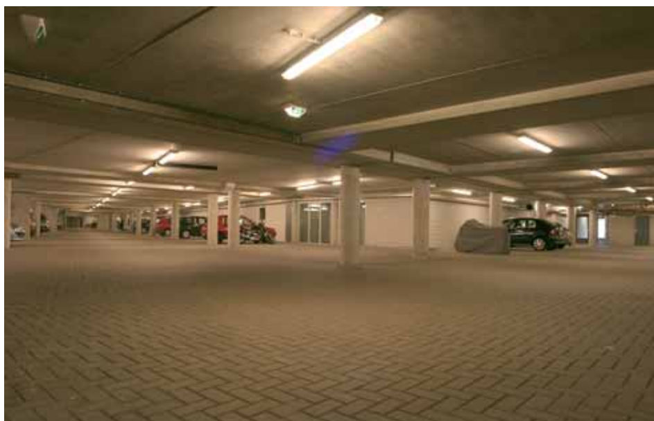
Een garage moet overzichtelijk en goed verlicht zijn
